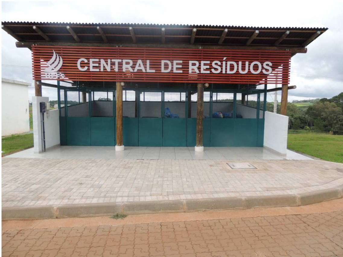
Figura 17- Central de resíduos
