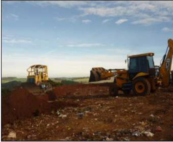
Figura 18 - Compactação da célula em operação
