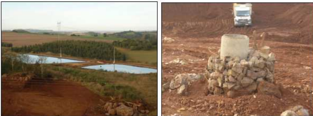
Figura 19 - Sistema de tratamento de chorume e queima de gases respectivamente.
